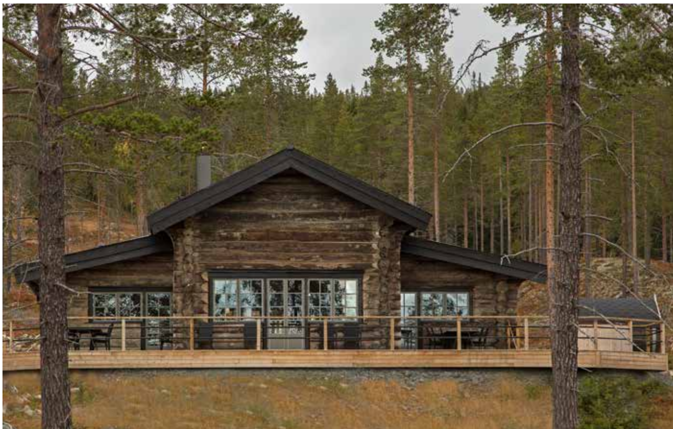
Byggnad i rundtimmer på Himmelfjäll
