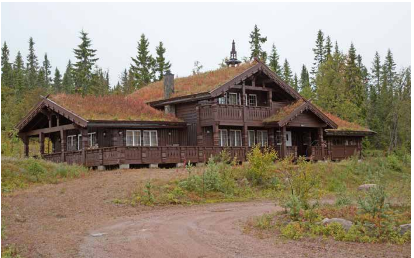
Lekfull användning av timmer och uppdelning i flera volymer som adderats. Genomarbetat stolpverk med pelare och balkar som är skulpterade. Foto från Trysil.
