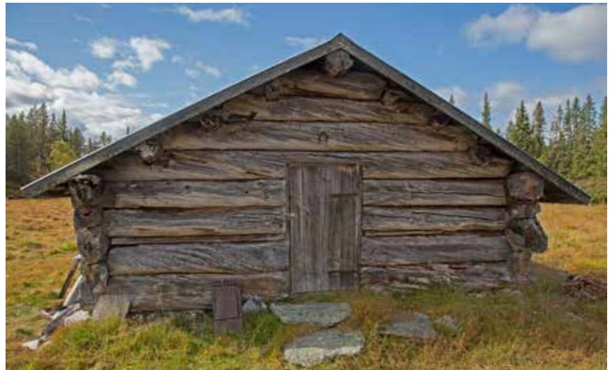
Rundtimmerbyggnad vid Gjotens säter i Grövelsjön
