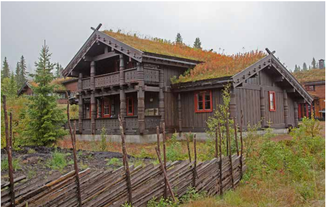
Byggnaden hålls samman på grund av nyttjandet av grovt stående eller liggande trä och en sammanhållen färgsättning. En stor lekfullhet i utformning av stolpar, vindskivor och räcken gör byggnaden helt unik. Gavelfasaden delas upp genom stolpverk och bärande konstruktion. Foto från Trysil.
