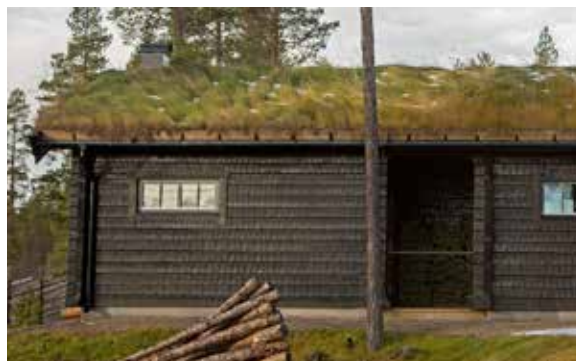
Planktimmer i kombination med torvtak
